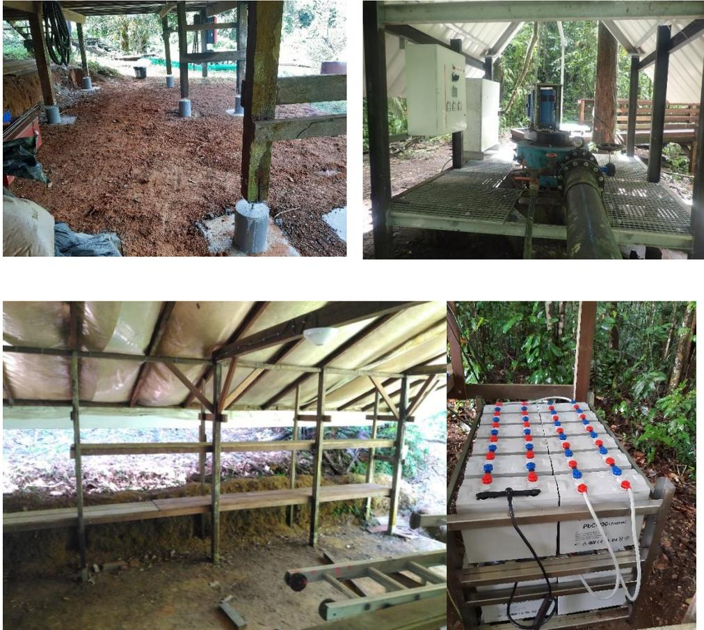
Figure 3 : Différents chantiers d'entretien sur les sites. En haut à gauche : pieds de poteaux du carbet laboratoire de Pararé, en haut à droite : chantier d'infrastructure pour l'extraction de la turbine (carbet, pont roulant, etc.), en bas à gauche : nouvelle étagère de rangement carbet stockage Inselberg. En bas à droite : remplacement des anciennes batteries du système solaire d'Inselberg par des batteries sèches, un onduleur et un régulateur. (@ Nina Marchand et Bran Leplat)
